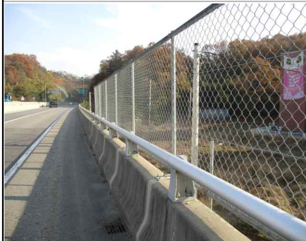
난간 및 연석 전경
